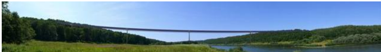
Рисунок 9: Конвейер, пересекающий р. Оку (фотомонтаж)
