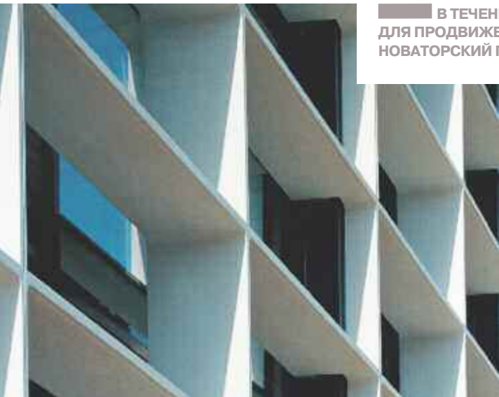
> Реставрация основного фасада муниципального бассейна в Клиши-ла-Гаренц, Франция, с помощью горизонтальных планок решетки Ductal®.
